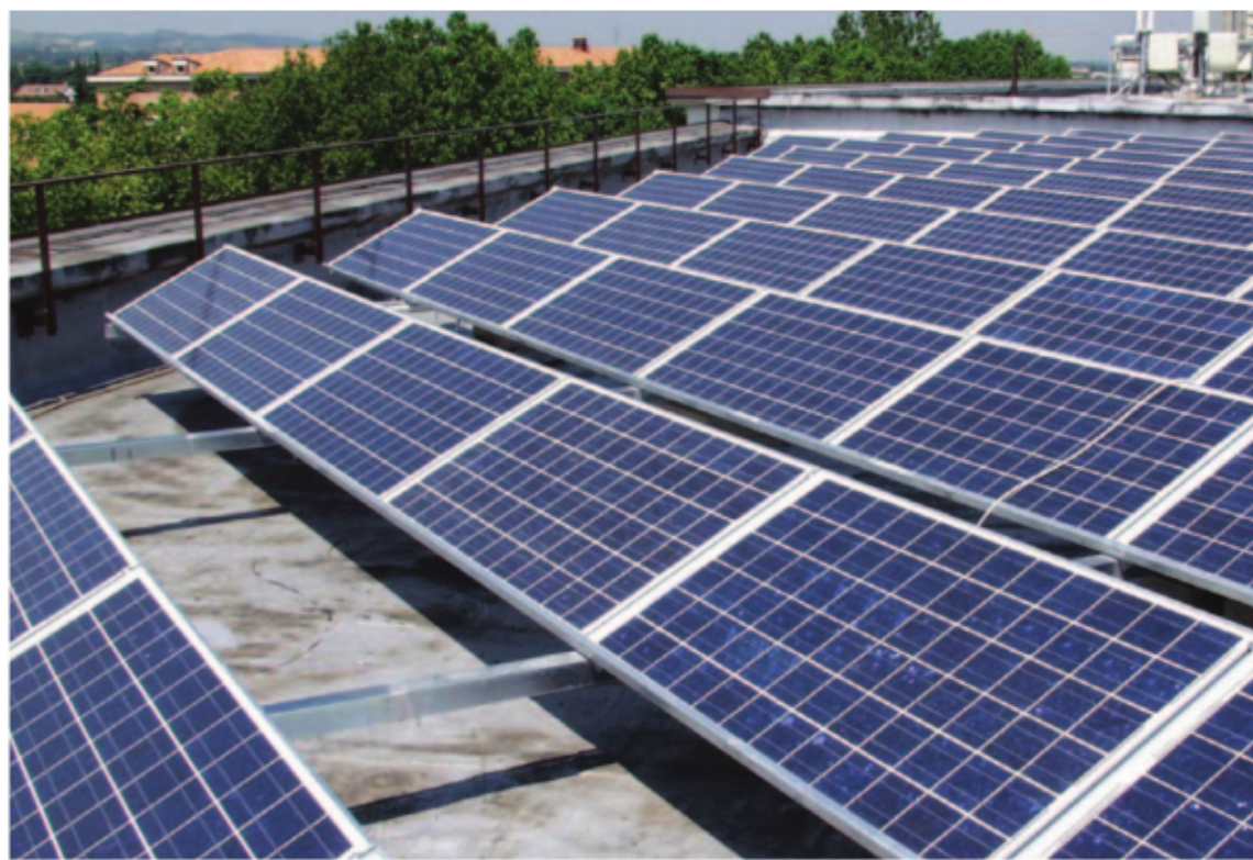
Il progetto prevede l'installazione di 24 nuovi impianti fotovoltaici integrati in edifici (IMMAGINE GENERICA D'ARCHIVIO)
